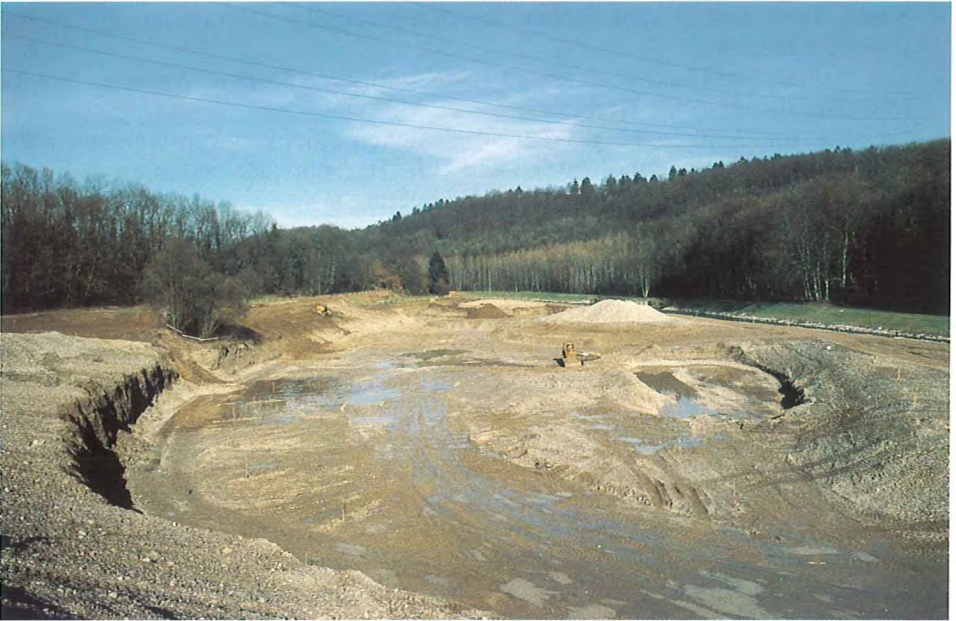
Abb. 4. Kurz vor Abschluss der Geländegestaltung im Februar 1980.
